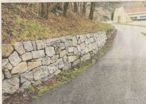
Patrimoine et emploi a réalisé plusieurs chantiers au Parc de Wesserling, dont la réfection de murs en pierre sèche. Photo L'Alsace
