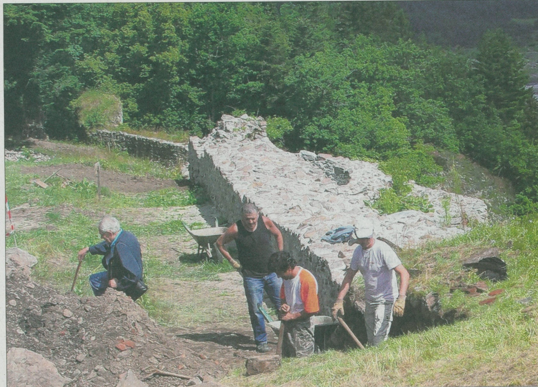
Les salariés de Patrimoine et emploi seront sur le site durant tout l'été pour remettre au jour et rehausser le mur d'enceinte du château.
