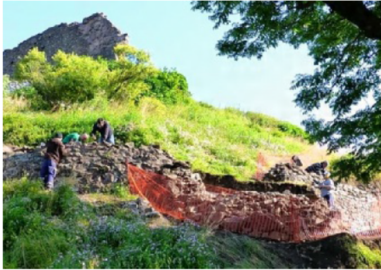
Le chantier de réhabilitation se poursuit à l'Engelbourg.
