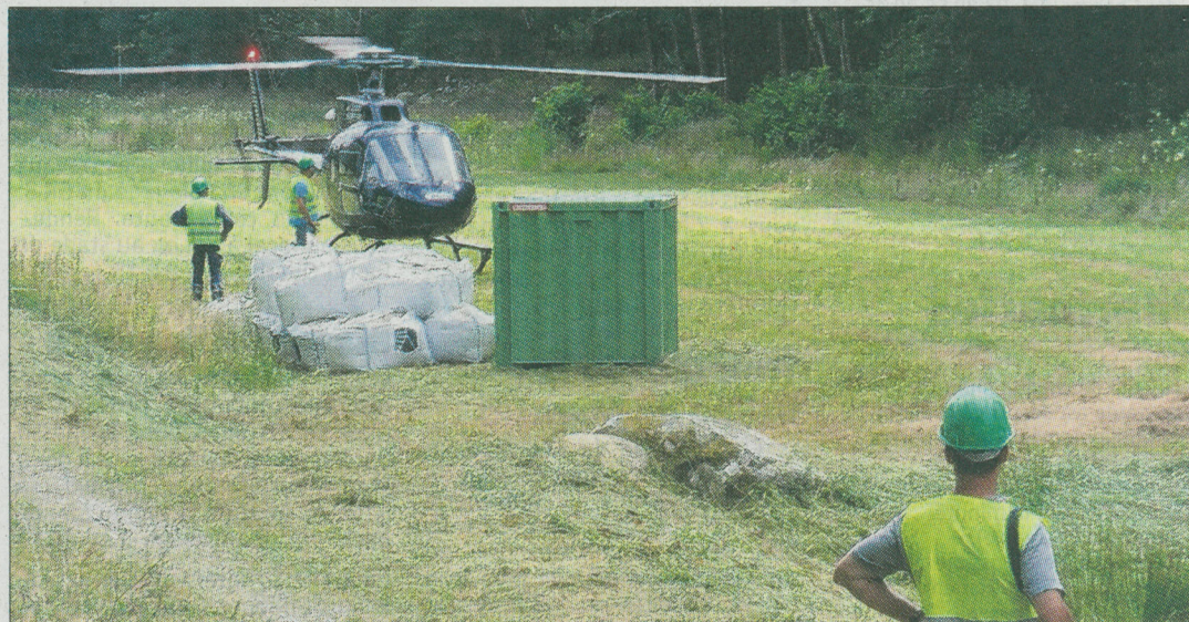
L'hélicoptère a transporté des matériaux de construction au sommet du Schlossberg.
