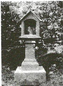
C'est une opération minutieuse : cm<sup>2</sup> par cm<sup>2</sup>, on va procéder à une technique de nettoyage à sec avec du sable très fin projeté par une aérogommeuse. Il faut compter une à deux journées pour remettre à neuf l'un de ces petits monuments.
