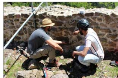
Les cordistes ont installé des ancrages en inox, avec du scellement chimique, dans la pierre. Ils ont ensuite testé la résistance à 500 kg avec un extractomètre. Photo L'Alsace
