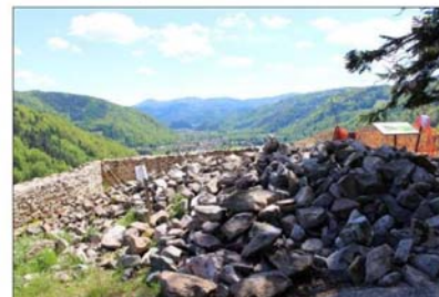
Les tonnes de pierres ramassées en octobre dernier par des bénévoles vont servir à colmater la brèche et à remonter le mur. Photo L'Alsace
